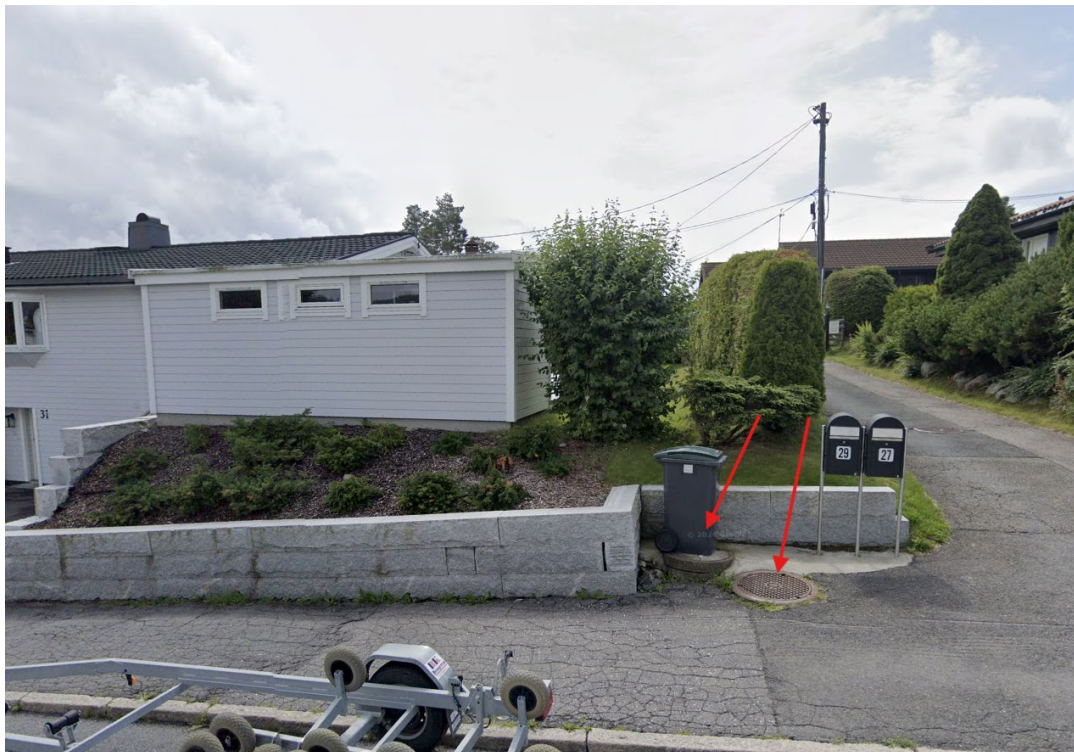
Figur 2: Mur ved kumgruppe 2 i Bjartveien. Pilene viser plassering av eksisterende kummer.
